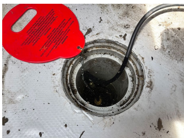
Obr. 19 Retenční zkouška RZ1
