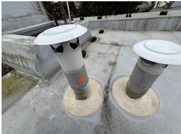
Obr. 15 Vadné napojení
