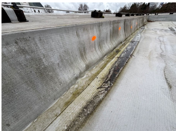
Obr. 17 Uvolněná koutová lišta
